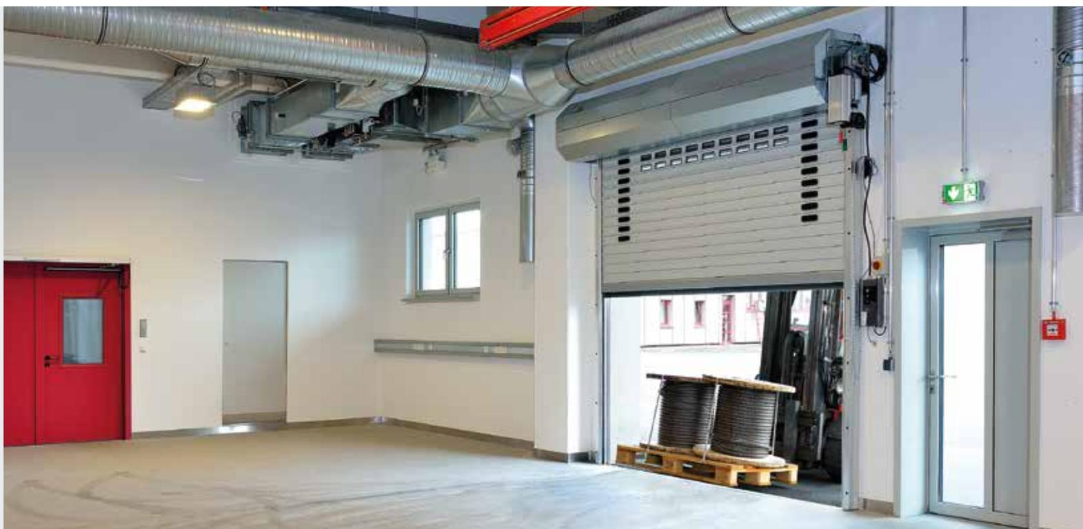
La vitesse élevée d'ouverture et de fermeture (jusqu'à 1,1 m/s) permet d'optimiser les processus et de réduire les déperditions thermiques.
