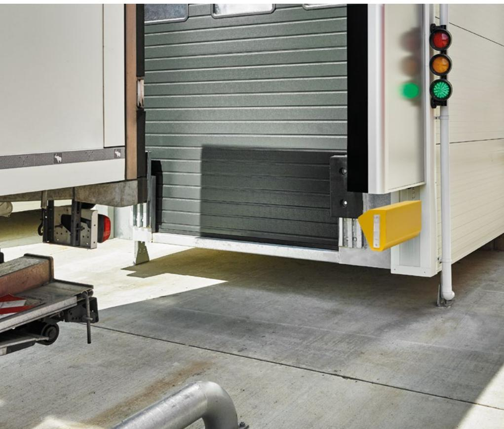
EN HAUT A GAUCHE. Le guide-roues en acier assiste le chauffeur lors de l'accostage. La cale de roue WSPG avec capteur libère le quai de chargement uniquement après le contact avec la roue.
