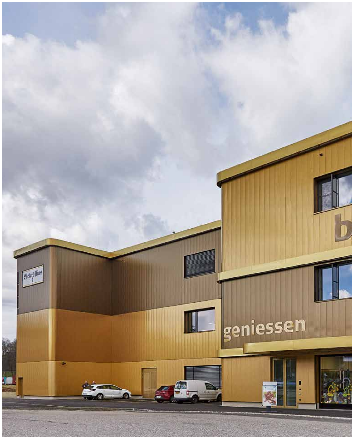
Laeckerli Huus, Frenkendorf, Suisse Architectes : ffbk Architekten AG, Münchenstein / Bâle
